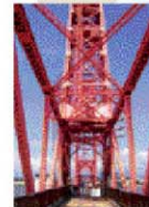
〈社会インフラの点検〉 (写真：日本最古の関門橋)
