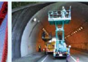
〈トンネル劣化調査〉
